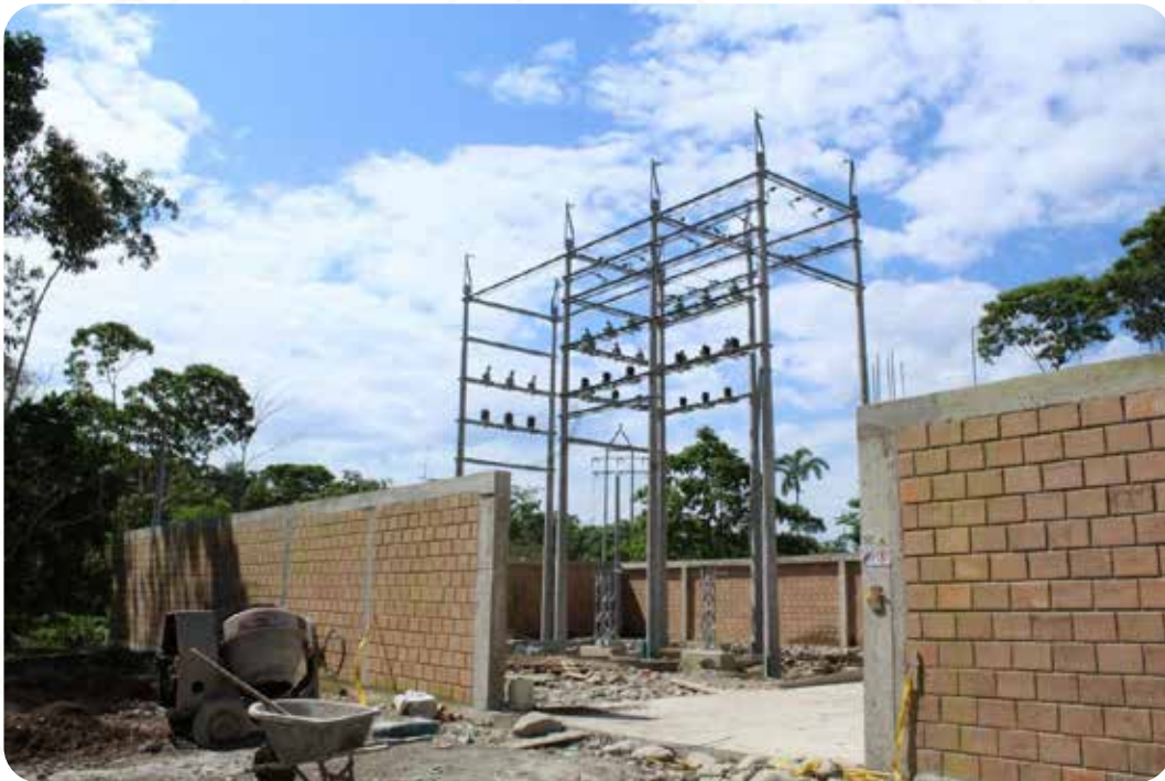
Construcción de la Subestación Piamonte.
