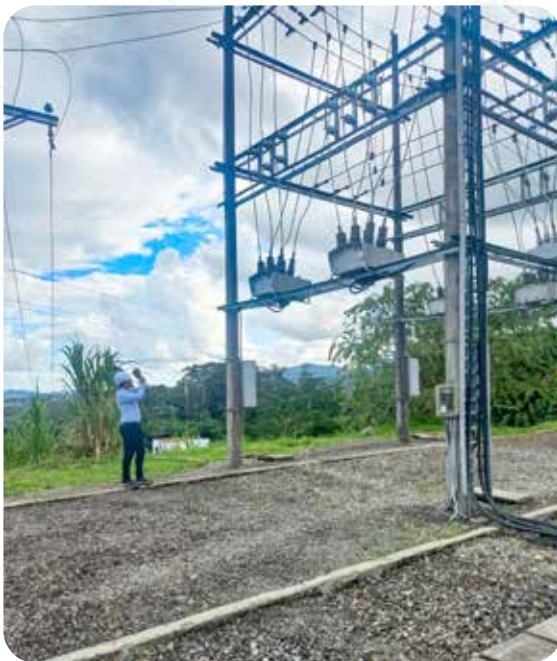
Termografía Pórtico -Junín, Cambio de reconector barra 13.2 kV -Junín
