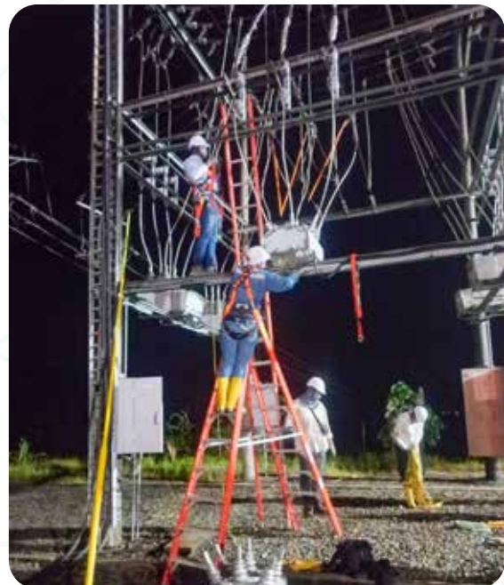
Termografía Pórtico -Junín, Cambio de reconector barra 13.2 kV -Junín
