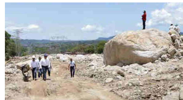
Imagen 24. Zona adyacente a Subestación Junín totalmente cubierta por rocas lodo en proceso de asentamiento.
