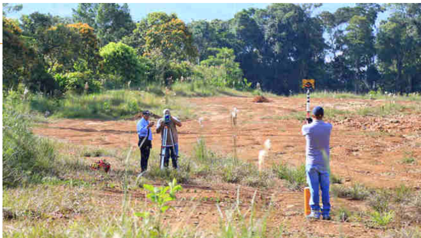
Imagen 19. Topografía sobre el terreno destinado a la instalación de una subestación móvil para suplir el servicio de energía eléctrica en corto plazo.
