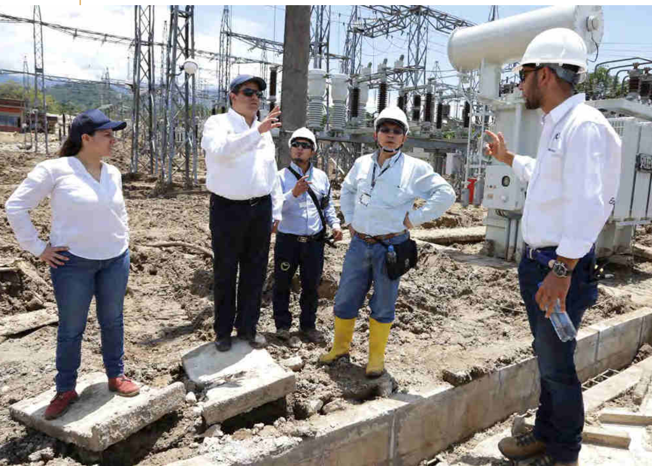
Imagen 22. Visita de reconocimiento a la Subestación Junín realizada por el Ministerio de Minas y Energía.
