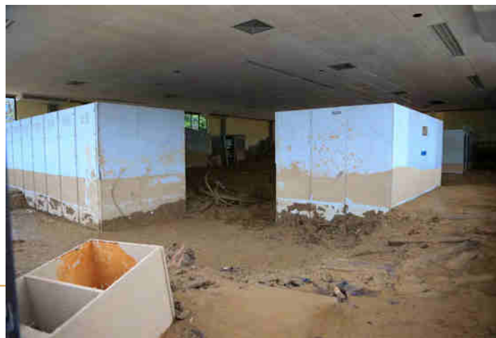
Imagen 10. Los equipos de control y protecciones ubicados en el cuarto de control permitían la operatividad de los activos del patio.
