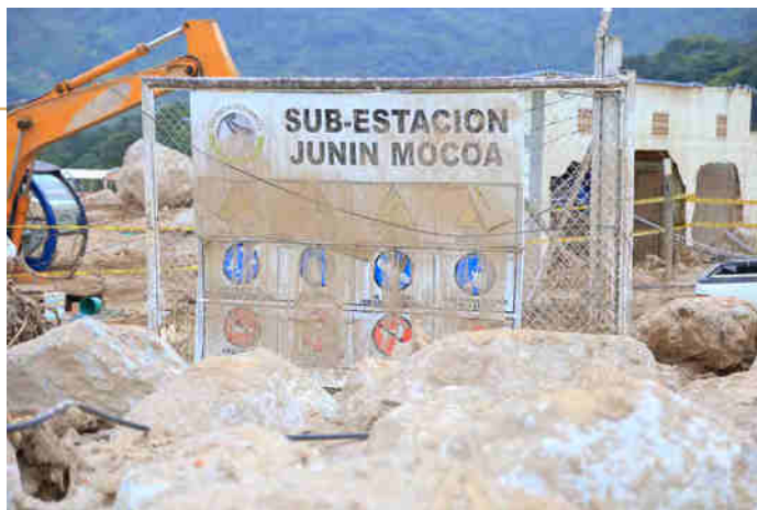
Imagen 7. Los daños causados sobre la subestación Junin afectaron los equipos eléctricos de potencia y los equipos de control y protecciones.
