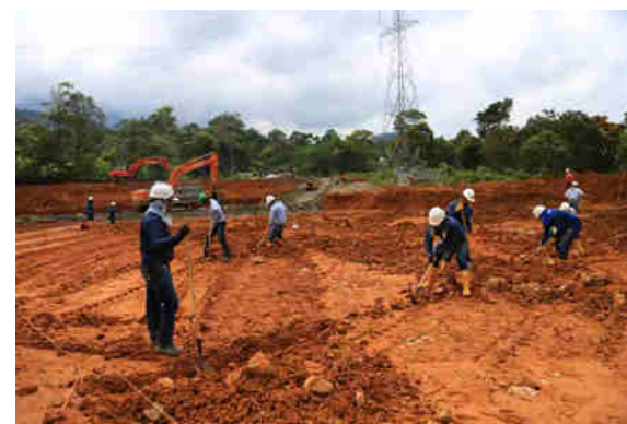
Imagen 23. Maquinaria y gran cantidad de personal fue requerido para las excavaciones y la conformación del terraplén para instalar la subestación móvil.
