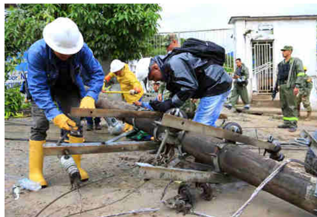
Imagen 13. Personal de la E.E.P. S.A. E.S.P. trabaja en la remoción de escombros para reconstrucción de redes.
