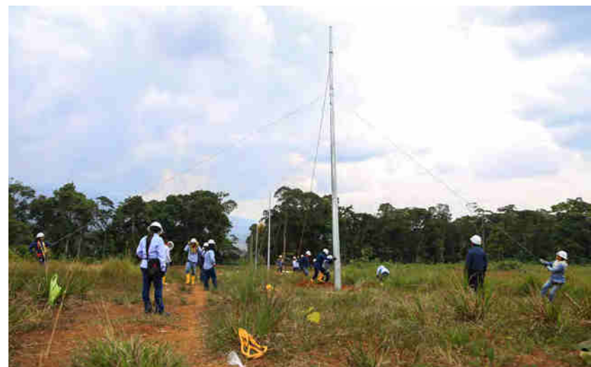
Imagen 35. Durante la emergencia se perdieron 274 postes que necesitaron ser repuestos rápidamente para extender redes eléctricas.
