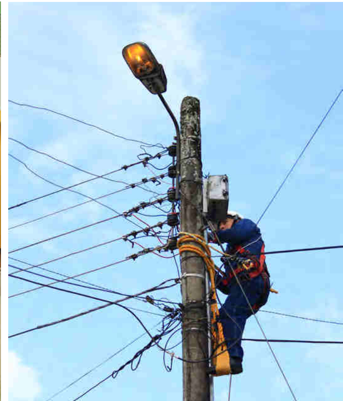
Imágen 54. Mantenimiento alumbrado público de Mocoa.
