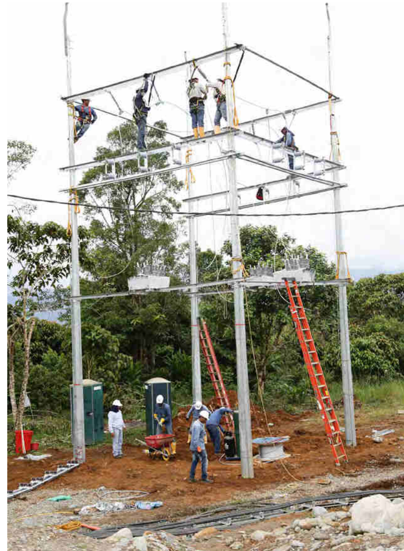
Imagen 51. Obras de mantenimiento construcción en el sistema de distribución local de Mocoa - Subestación móvil
