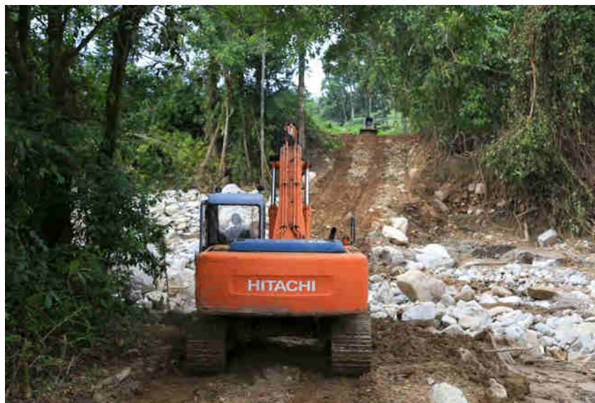
Imagen 25. Se hizo necesaria la apertura y despeje de vías de acceso para el transporte de los módulos de la subestación móvil.
