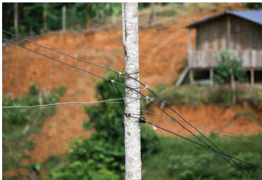
Imagen 50. Conexiones fraudulentamente detectadas en barrios subnormales de Mocoa, se procedió a la normalización de los usuarios para recuperación de energía.
