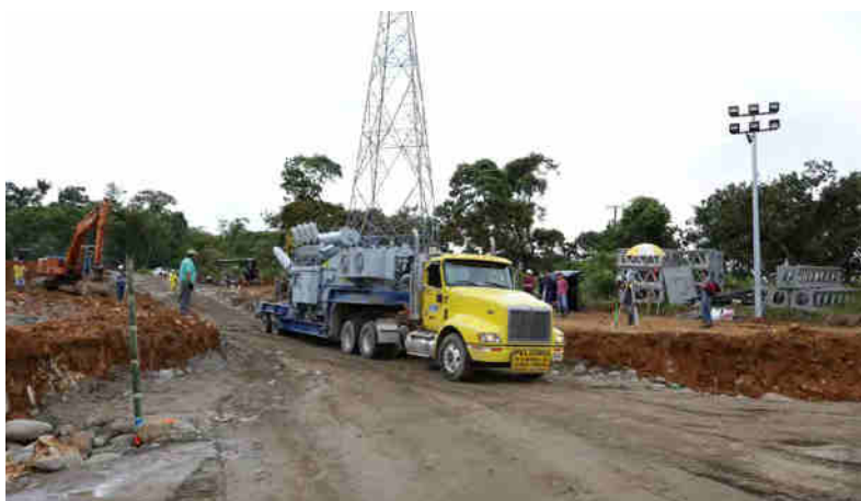
Imagen 39. Llegada de los módulos de operación y equipos necesarios para la instalación de la subestación móvil.
