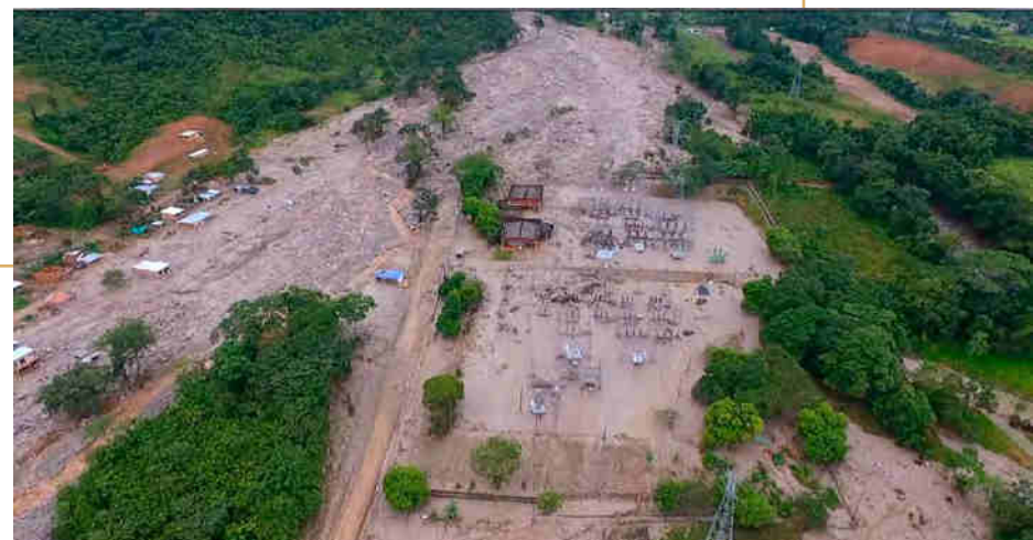
Imagen 5. Imagen aérea Subestación Junin 1 de abril de 2017.
