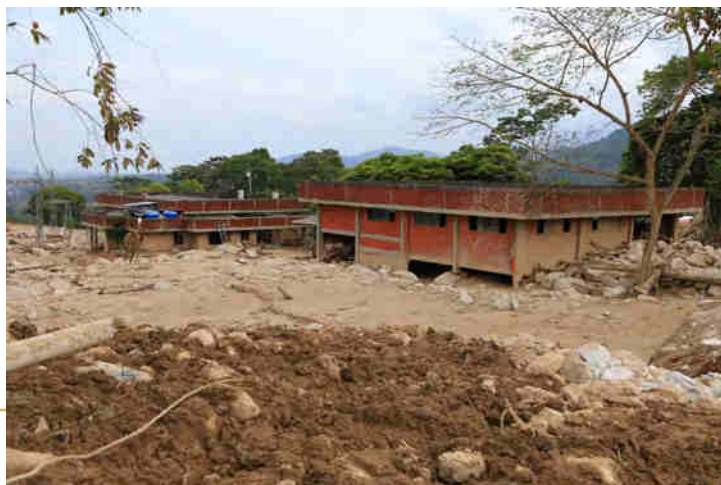
Imagen 9. Bodega y cuarto de control de la subestación Junin totalmente destruidos.
