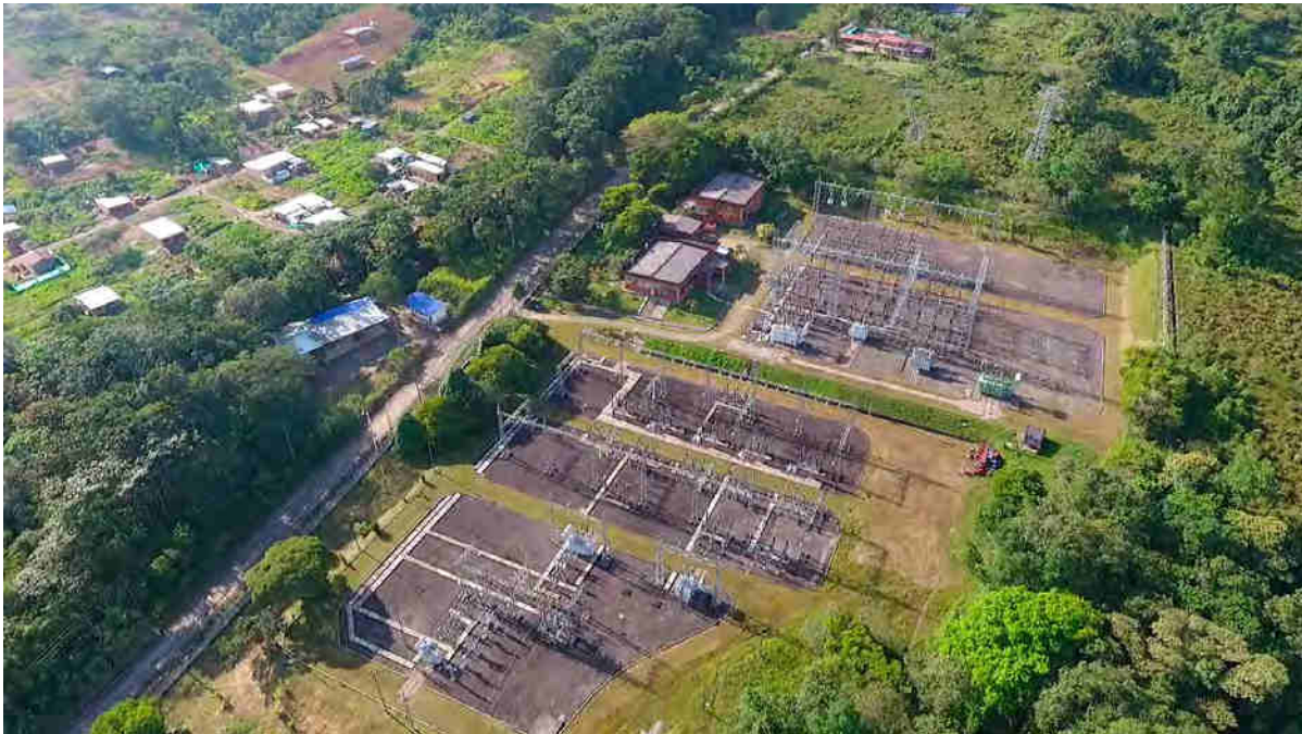
Imagen 4 . Imagen aérea Subestación Junin 29 de marzo de 2017
