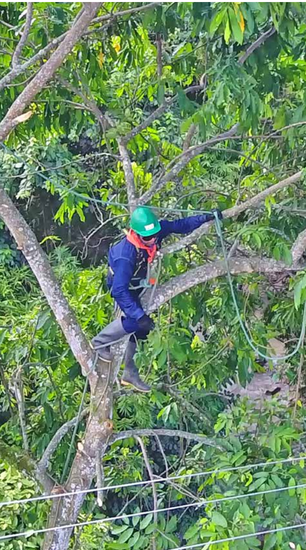
Imagen 14. Labores de despeje de redes eléctricas.
