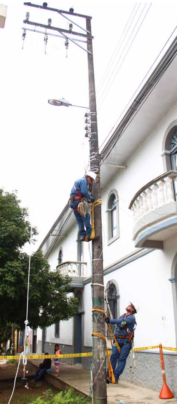
Imagen 27. Capacitación trabajo seguro en alturas.
