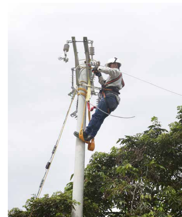
Imagen 5. Trabajos de ampliación de redes.
