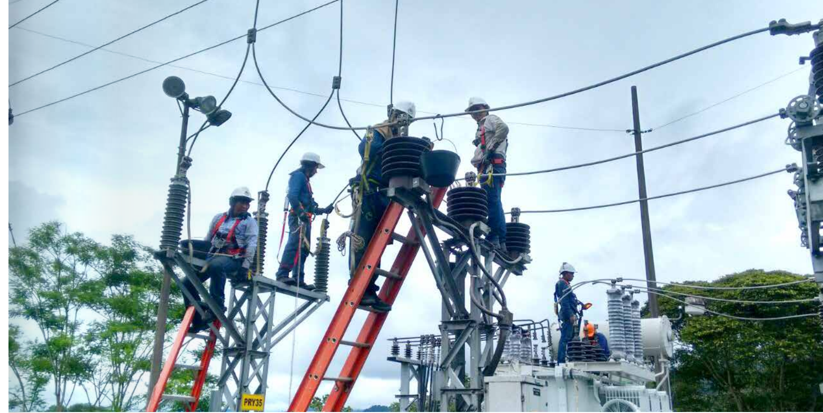
Imagen 15. Labores de mantenimiento a subestación Junín.
