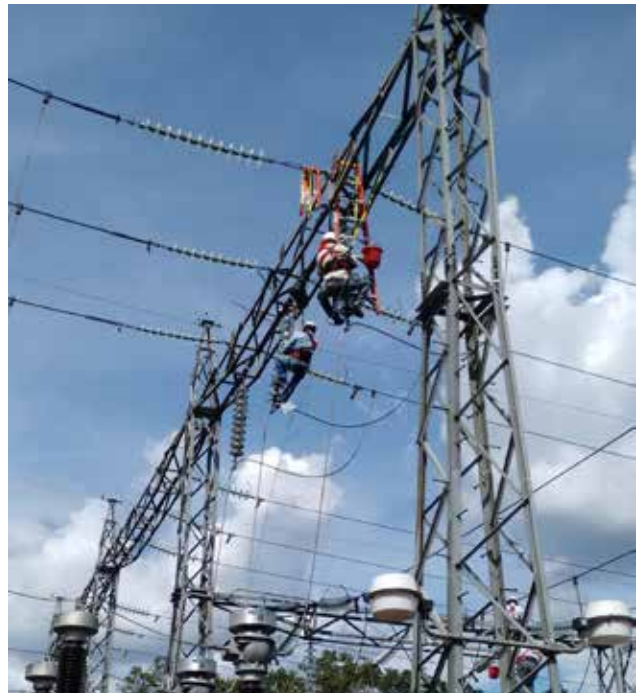
Personal realizando mantenimiento a la subestación Junín - Mocoa..
