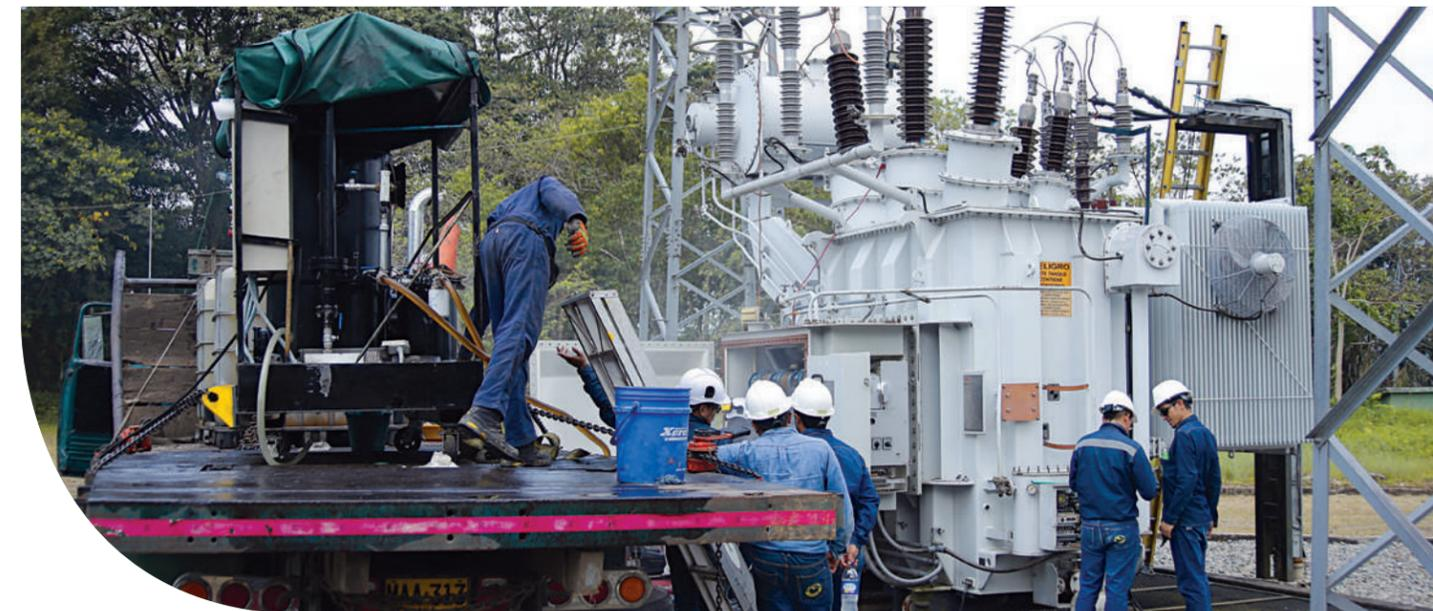
Foto 7. Mantenimiento de transformadores en subestación Junín
