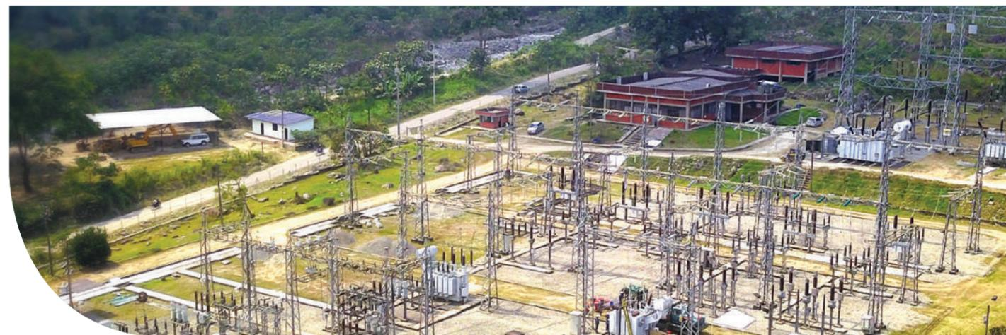
Foto 6. Subestación eléctrica Junín operando a 230 kV
