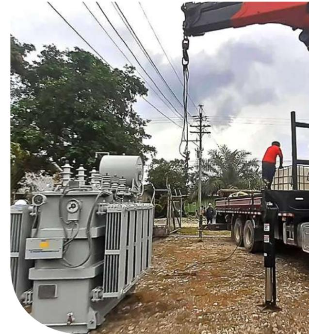
Foto 10. Instalación de transformador en subestación Puerto Guzmán
